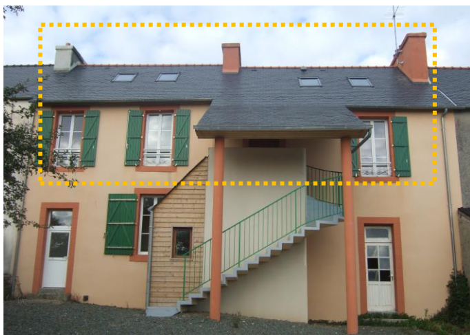
Façade arrière (entrée)
